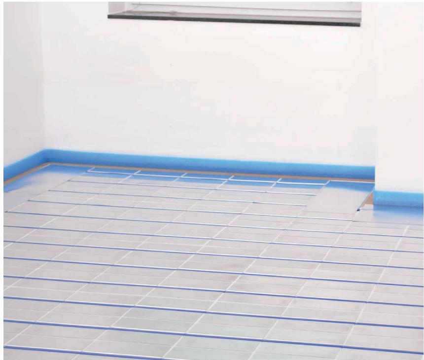
Fertig verlegte Fläche CompactFloor IDEAL BASIC – Bis zur Verlegung der Lastverteilschicht oder des Oberbodens Laufwege, z.B. mit Dämmplatten, vor Stauchung schützen. Der Oberboden kann direkt verlegt werden.
