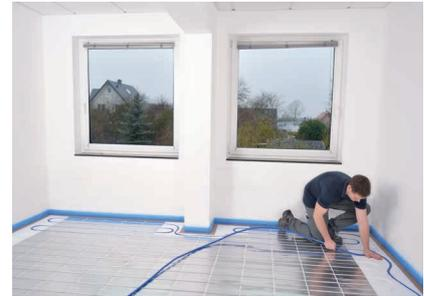
Das Rohr fest in die Rohrführungen eindrücken. Bei Bedarf das Rohr
