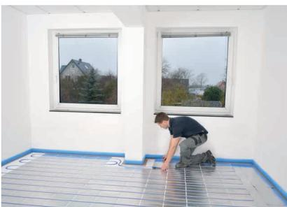
Kopfelemente mit Aluminiumblechen versehen, sodass diese flächig mit diesen verdeckt sind.
