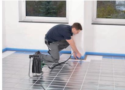
Mit dem Heißschneider individuelle Rohrführungen ausschneiden. Lange Rohrführungen in Wellenlinien ausschneiden.
