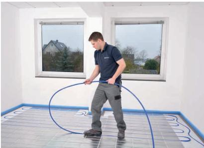
Systemrohr in einem großen Bogen von oben spannungsfrei in die Rillen drücken. Maximale Heizkreislänge 100 m.
