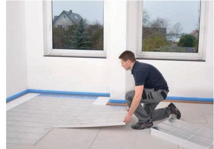
Die mit Wärmeleitblechen aus Aluminium versehenen Heizelemente vollflächig im Raum auslegen.
