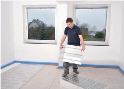
Elemente mittels Sollbruchstellen anpassen und Rand- und Eckbereiche mit Randelementen auffüllen. Niemals Aluminiumbleche schneiden!
